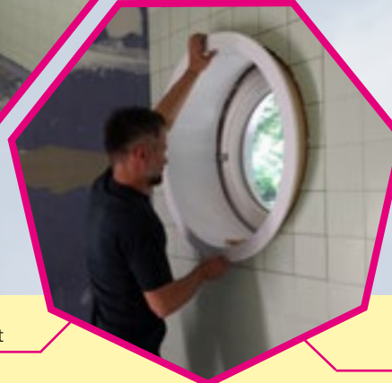
Im Bad wird das „Bullauge“ eingepasst
