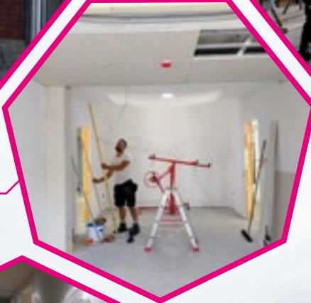
Einbau der Schallschutzplatten
