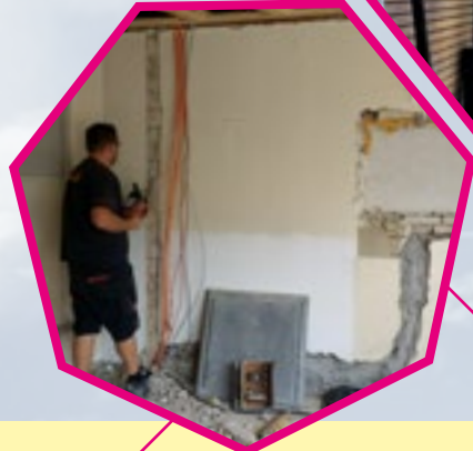
Die Kabel sollen unter Putz - Stemmarbeiten im Gruppenraum
