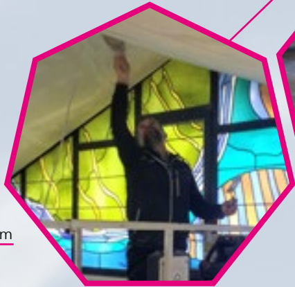
Einbau der Brandschutzplatten im Heptagon
