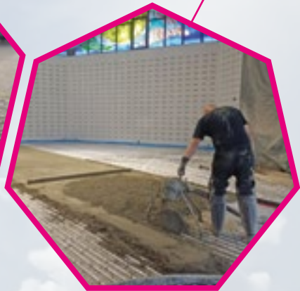
Fußbodenheizung und Estricharbeiten im Heptagon
