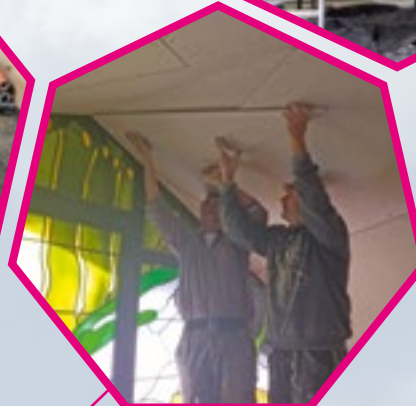
Der Rauputz wird aufgebracht
